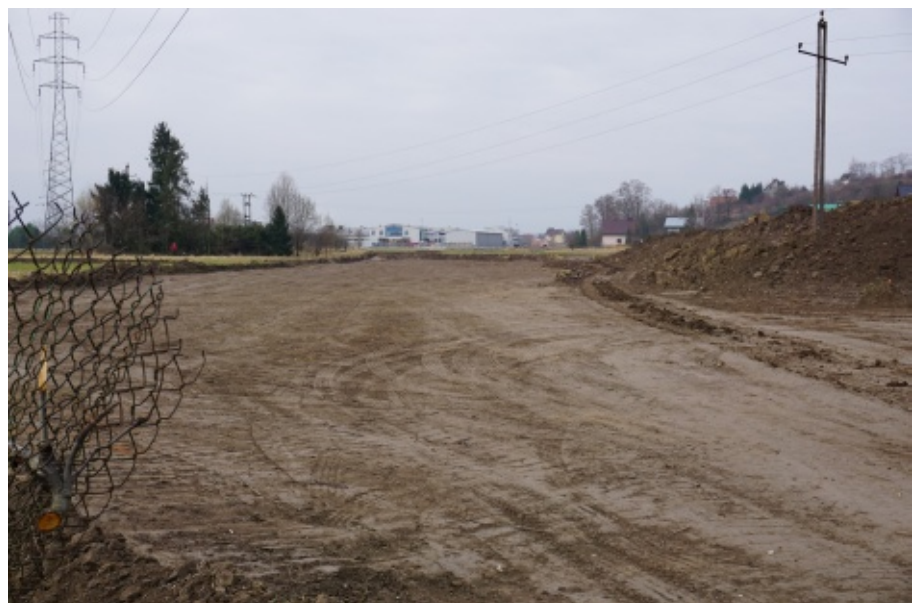
Ruszyła budowa obwodnicy Chełmca
