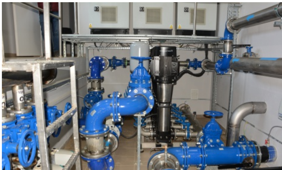
Inwestycja wodociągowa w Marcinkowicach
